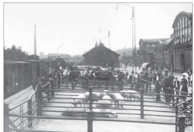
Abb. 5 Viehhof mit Eisenbahnanschluss (links) um 1900
