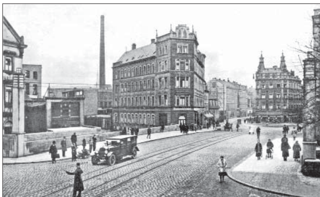
Abb. 1: Die Hartmannstraße an der Hohen Brücke 1930; in Bildmitte das Haus Nr. 16 – danach führt eine leichte Linkskurve zur Rochlitzer Straße, nach rechts: „An der Markthalle“ und „Hinter der Klostermühle“
