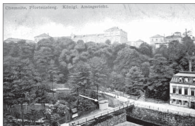
Pissoir am Pfortensteig
