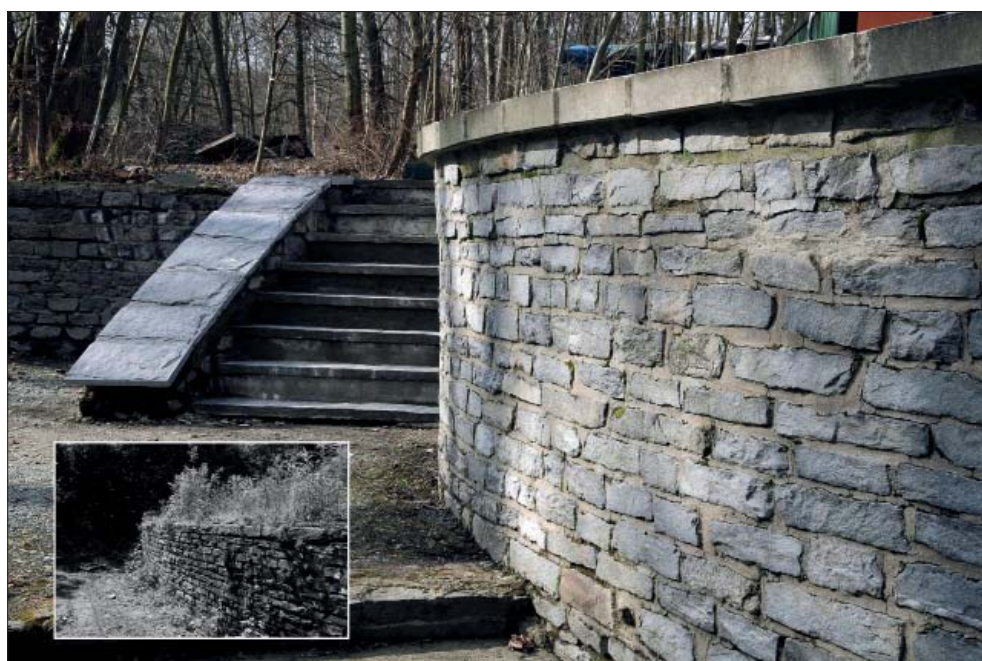
Sanierte Mauer mit Treppenaufgang
